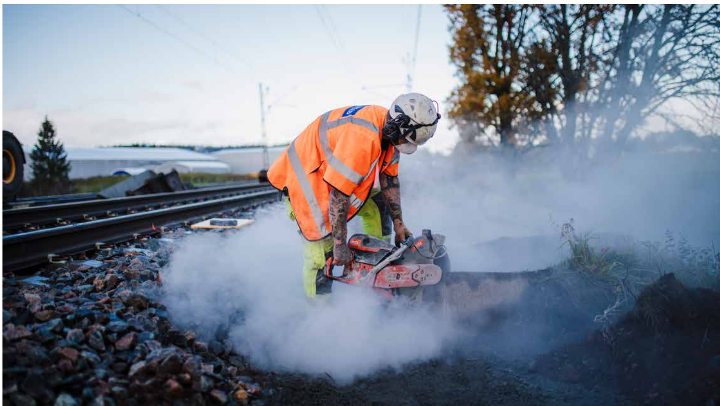
Vattenbegjuten kapning pågår.
