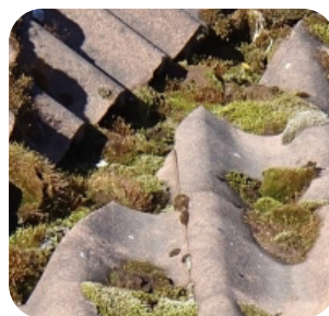
Besiktning & underhåll av tak
