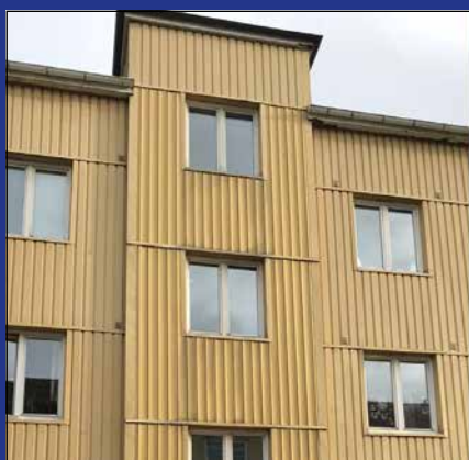
Fastigheten Landora - före och efter fasadrenovering.
