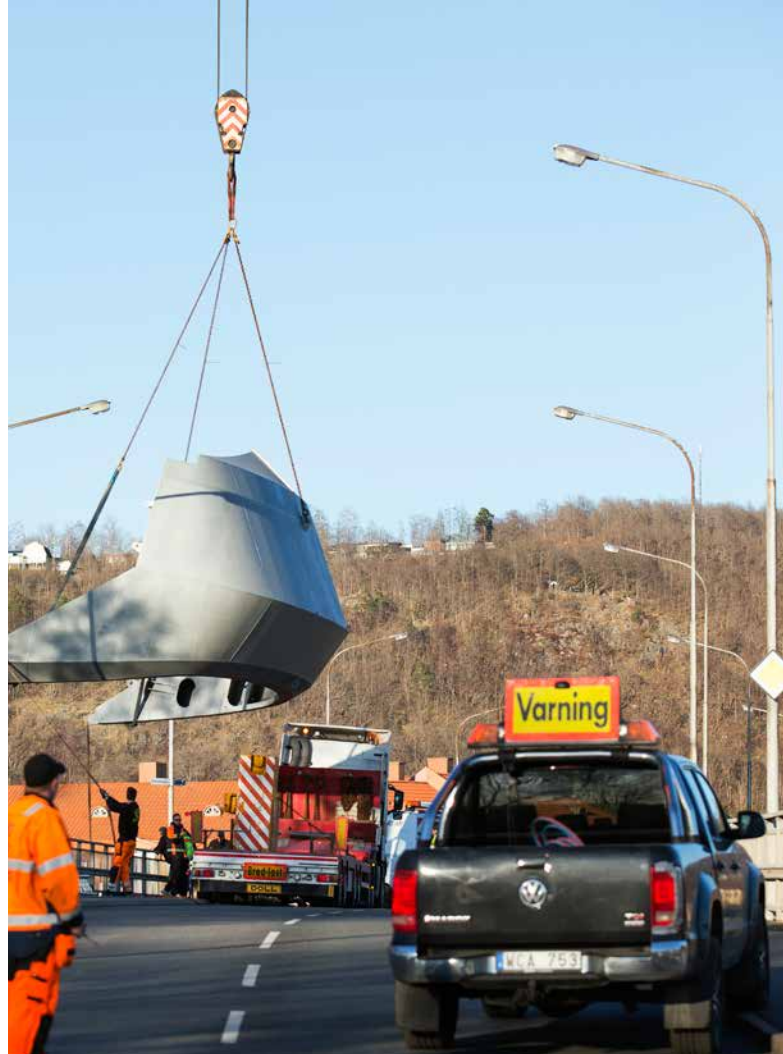
Lastbilen kom inte under bron med bogvisiret på flaket. Därför fick mobilkranen lyfta av bogvisiret medan lastbilen körde under bron och sedan lasta på det på andra sidan bron.
