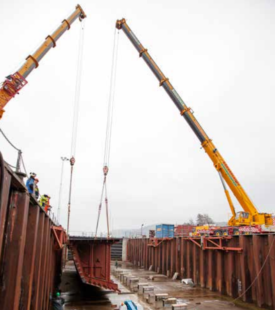
Första delen lyfts på plats i torrdockan, det är babords midskeppsdel.
