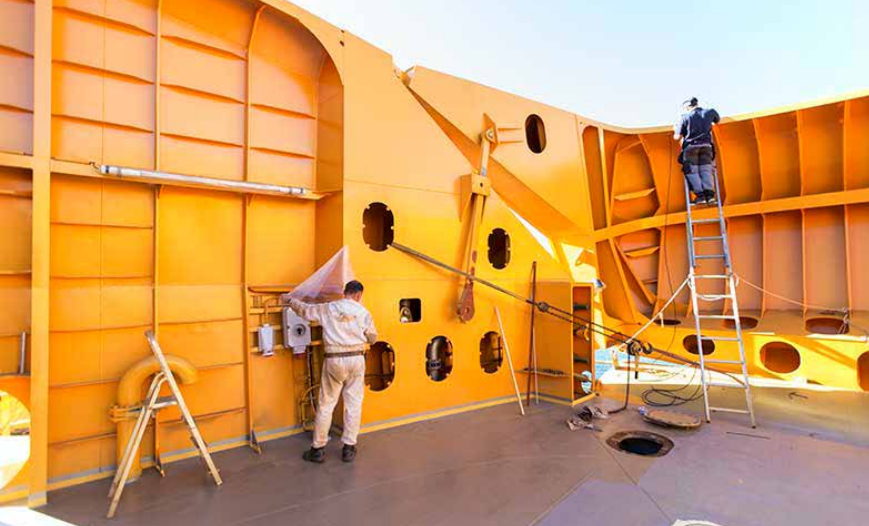
Som avslutning målades hela Braheborg i Trafikverket färjerederiets solgula färg.
