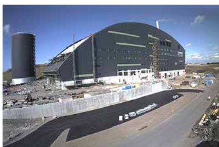
Byggnation av ackumulatör till Helsingborgs värmekraftverk Filborna.
