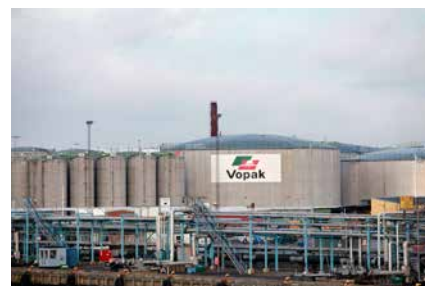
Byggnation av tankar för Vopak i Göteborg.
