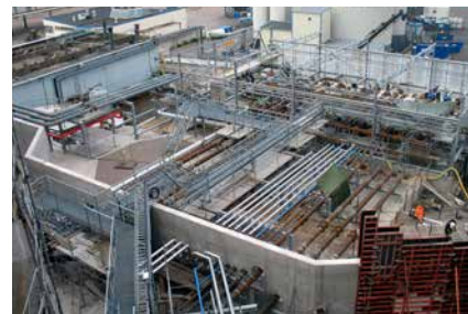
Byggnation av ett pumphus med tillhörande rör för Vopak i Göteborg.
