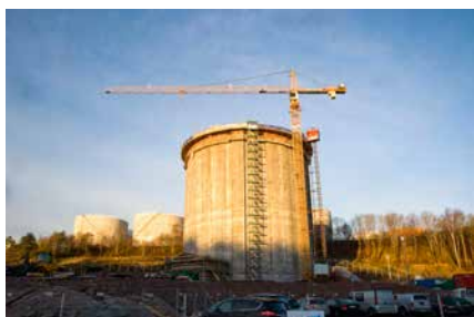
Byggnation av en LNG tank för Scangass.
