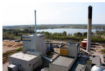
Växjö Energi byggnation av lyftkylare.
