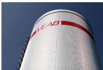
Växjö Energi byggnation av Fjärrvärme ackumulatör.
