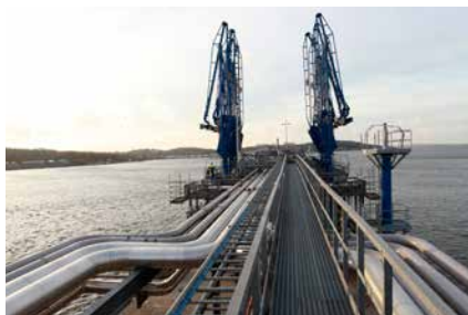
Byggnation av en av lastkajerna för Göteborgs Hamn.
