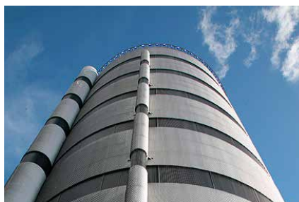
Byggnation av ackumulatören för Borås Energi.
